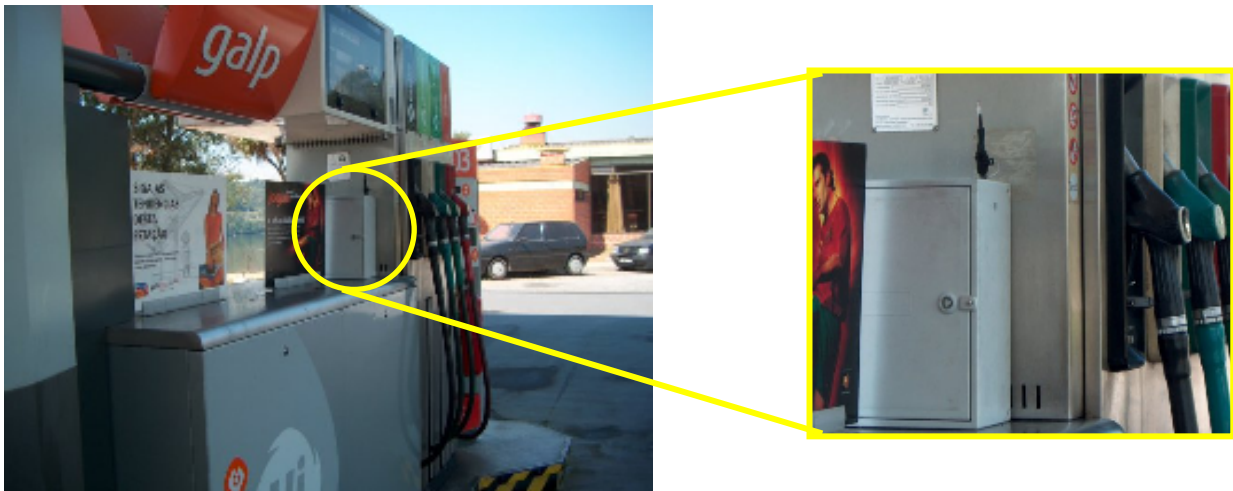
Figura 20: Posição do equipamento de amostragem nas bombas de abastecimento de combustível.
