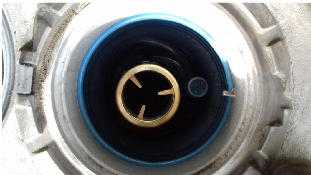
**Figura 15 – Boca de recebimento de combustível adequada para a descarga selada**
