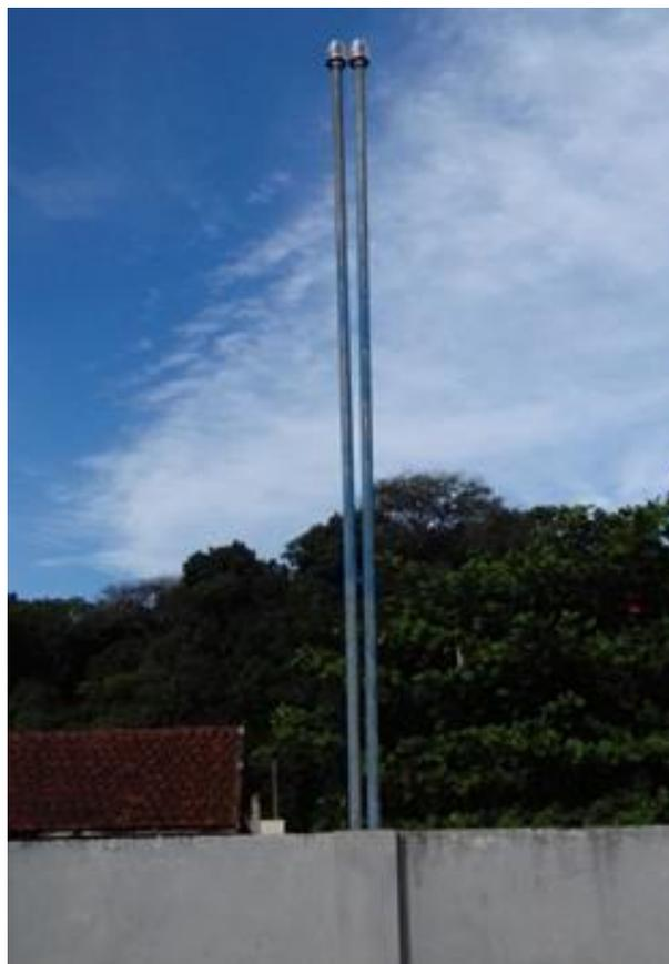
**Figura 13 - Respiros com a válvula de retenção de vapores**
