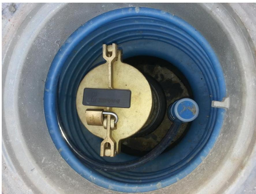
**Figura 12 – Câmara de contenção instalada na entrada do tanque**
