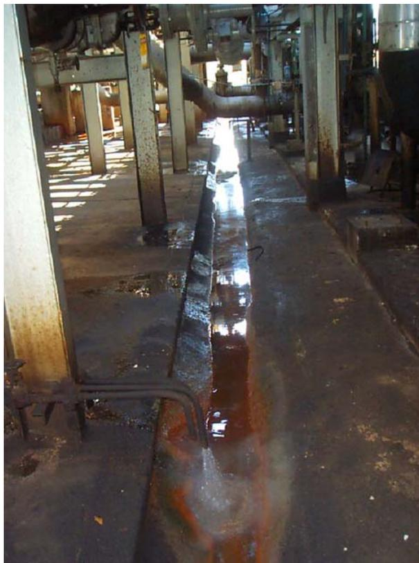
5: Canaletas da Área Leste. Além de gotejamentos, pode-se notar o provável afloramento de óleo a partir do solo.
