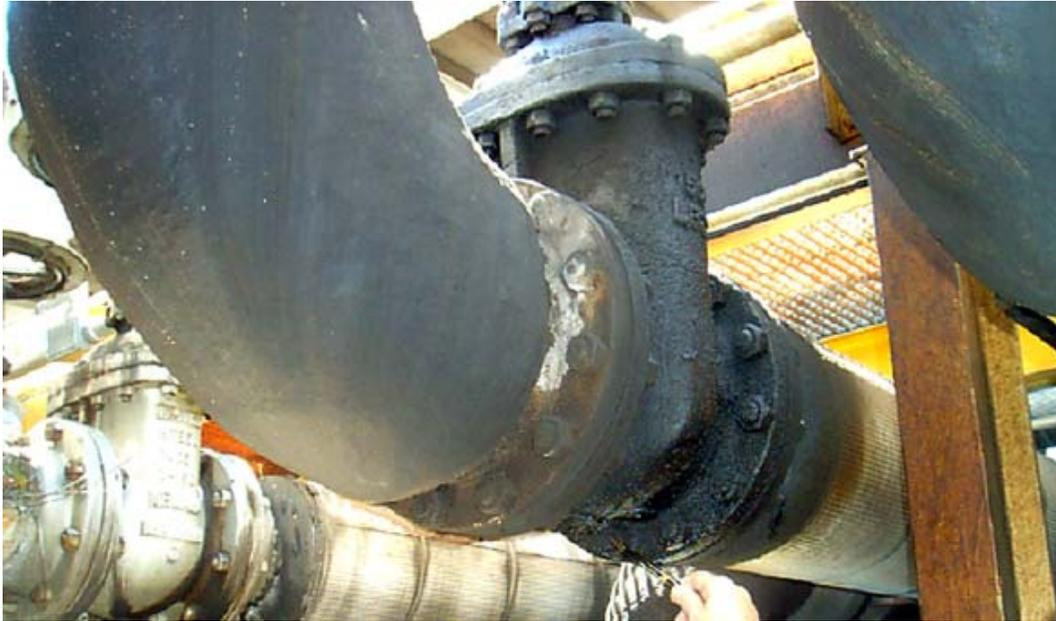
25: Vazamento em válvula de grande dimensão na Área Leste.
